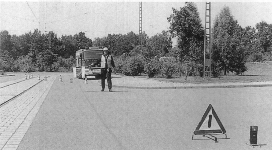
Sicherungsposten vor der Sperrung einer Fahrspur
